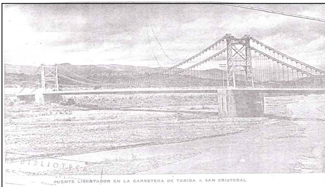
Foto7: Puente Libertador 1930. Fuente: El Taribero, (2004).
