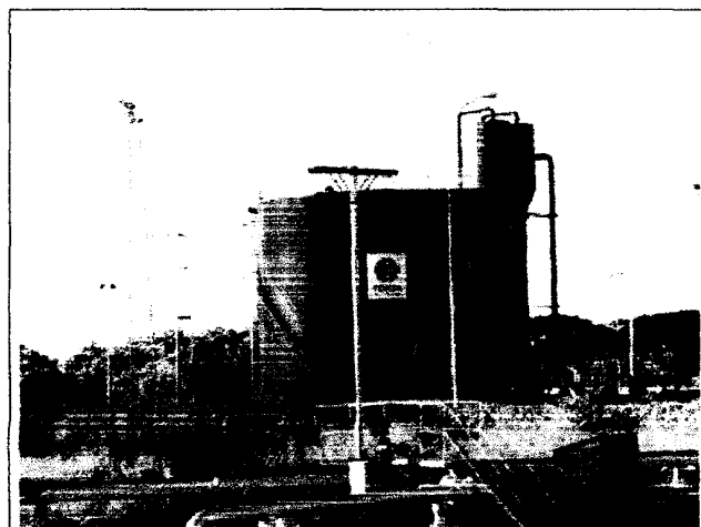
Figura 5.8 Tanque de lavado
