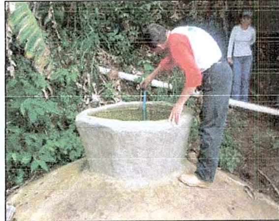
Figuras 5.8: Supervisión del biodigestor por parte del personal técnico a cargo del proyecto. (E. Hernández, 2006).
