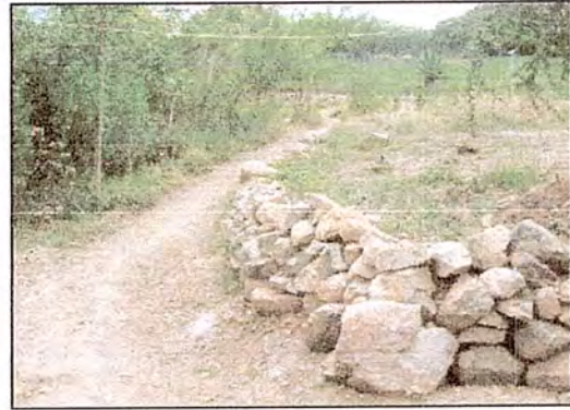
Figura 5.131: Muros de piedra que ha construido el productor, como parte de las acciones desarrolladas con el proyecto. (D.Dávila y A.Angulo, 2005)
