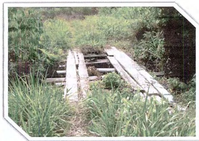
Figura 4.12. Puente rustico que posibilita acceso desde Waramasen hasta Wacauyen.
