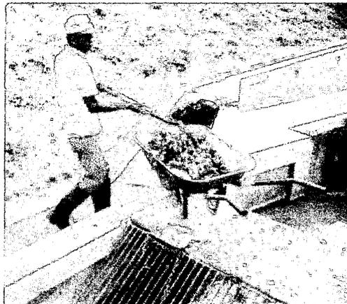
**Figura 3.10.** Operador realizando el mantenimiento de las rejillas.
