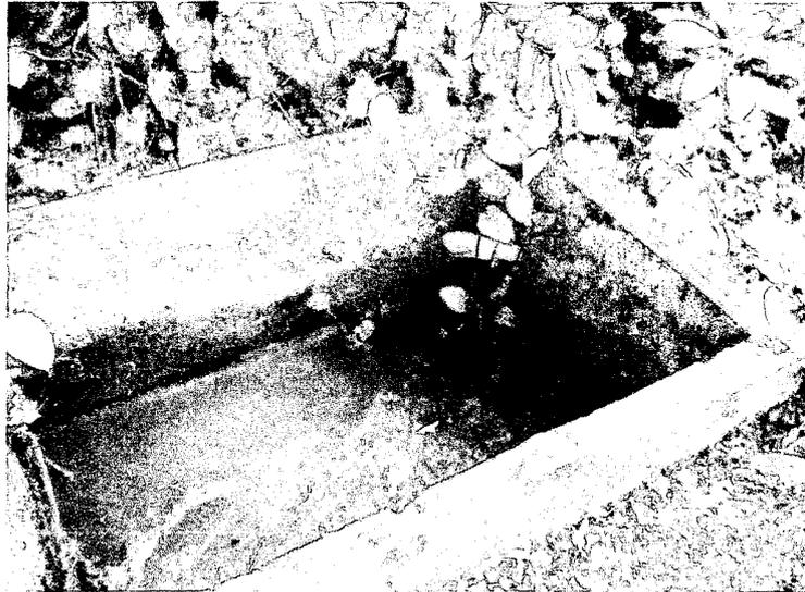
**Figura 4.4.** Tanquilla de entrada a la laguna. Se observa ausencia de rejillas.
