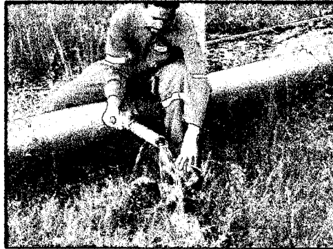
Foto III-19 Recolección de muestras en la población de Pedernales, en la tubería que conduce el agua desde el pozo de agua hasta la planta potabilizadora.
