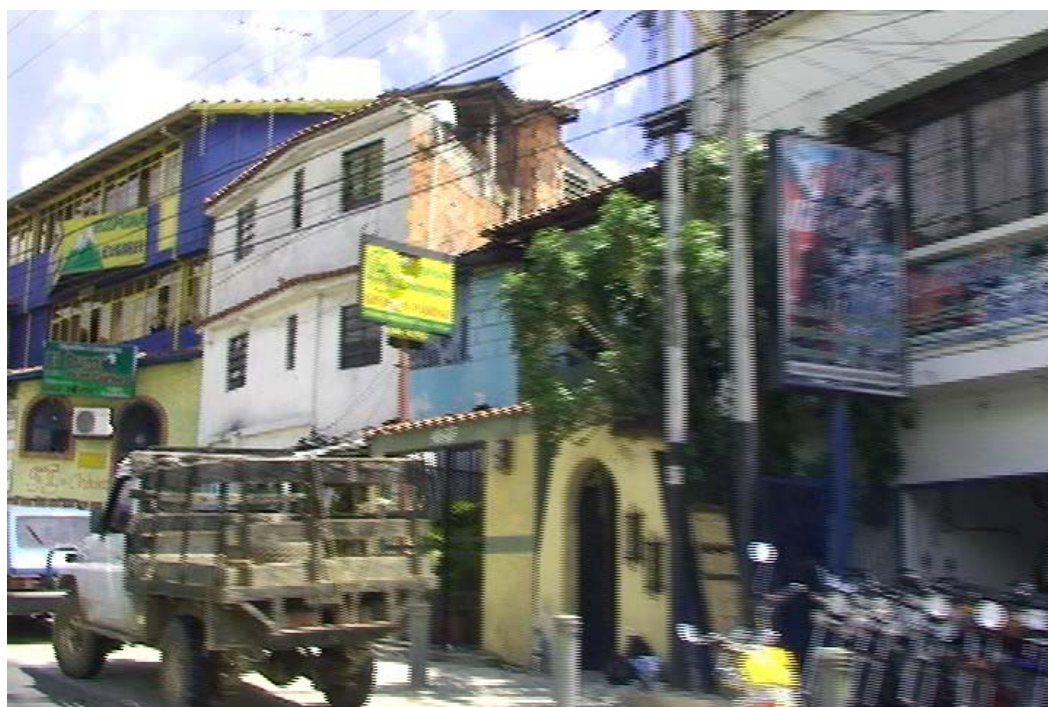
Figura 1.40. Vistas de la fachada con Avenida 16 de Septiembre.
