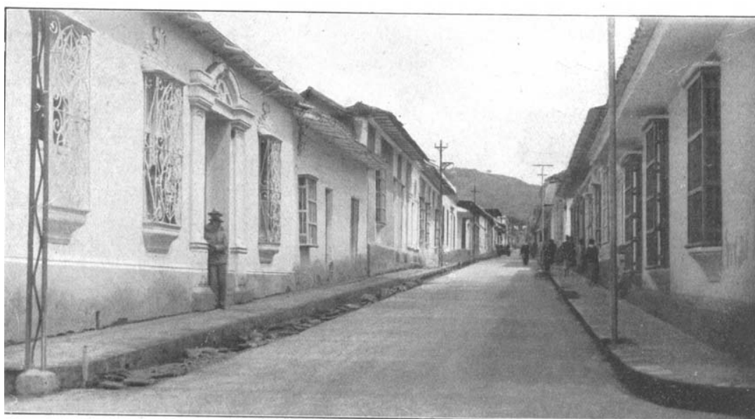
Figura 1.10. Calle 2 recientemente pavimentada con el sistema de concreto.
