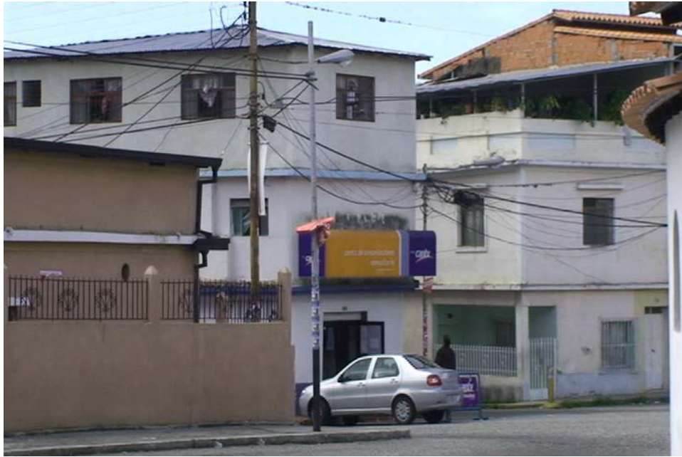
Figura 1.29. Avenida Buena Vista, entradas a calles 2 y 3 de Santa Elena.
