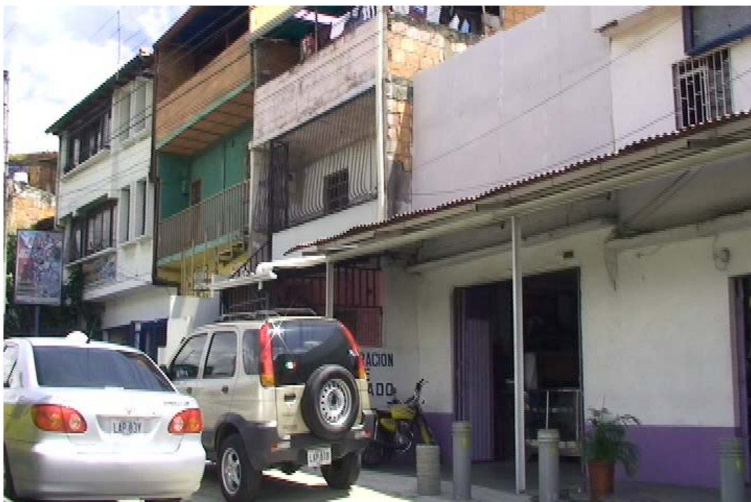
Figura 1.39. Vistas de la fachada con Avenida 16 de Septiembre.
