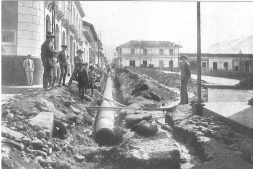
Figura 1.13. Construcción de cloacas en la calle Independencia y plaza Bolívar.
