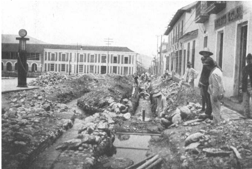
Figura 1.14. Construcción de cloacas en la calle Independencia y plaza Bolívar.
