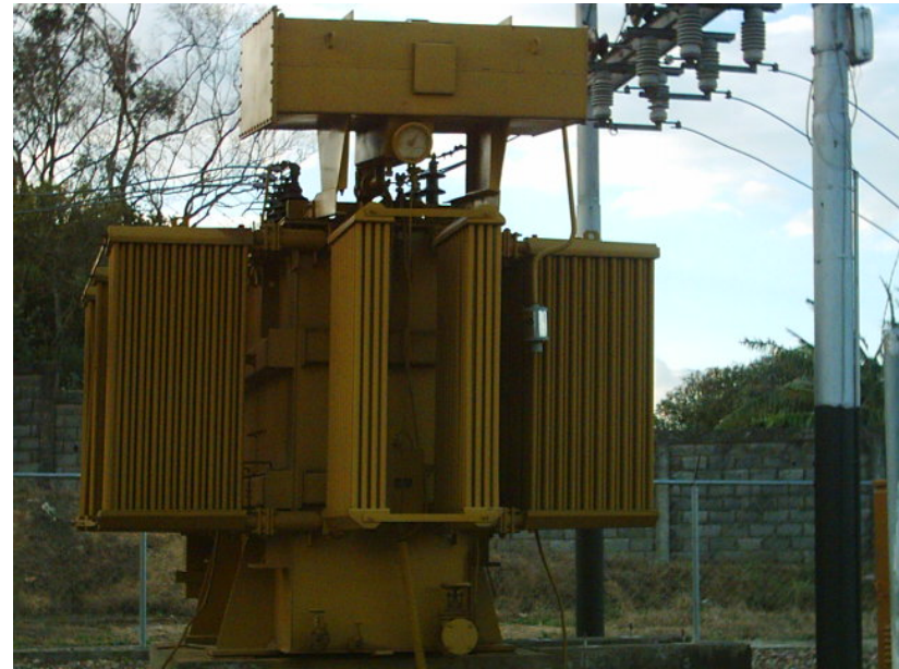
Fotografias 1 y 2 S/E Rubio, Capacidad instalada 16MVA, 34.5/13.8KV 8 Salidas.
