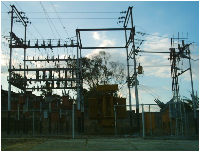
Fotografias 1 y 2 S/E Rubio, Capacidad instalada 16MVA, 34.5/13.8KV 8 Salidas.
