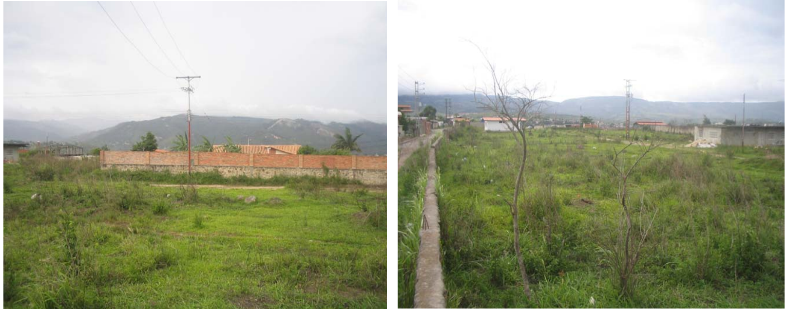
Fotografías 7 y 8, El circuito Ruiz Pineda en 13,8kV y el enlace en 34.5kV entre las subestaciones atraviesan el terreno.
