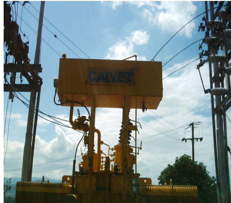
Fotografías. 3 y 4 S/E San Diego, Capacidad instalada 10MVA 34.5/13.8KV 4 Salidas.
