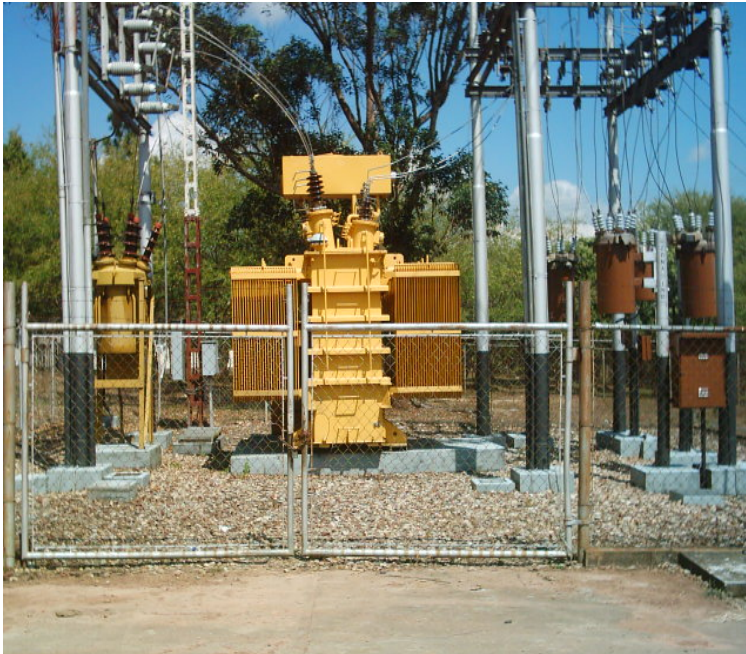
Fotografías. 3 y 4 S/E San Diego, Capacidad instalada 10MVA 34.5/13.8KV 4 Salidas.
